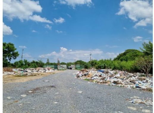
ขยะปลิวกระจายภายในสถานที่กำจัดขยะมูลฝอย
