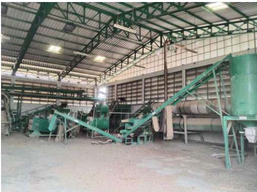
อาคารคัดแยกและทำปุ๋ยหมักไม่ได้ใช้งาน
