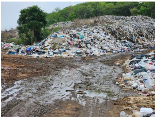
ถนนภายในที่เต็มไปด้วยน้ำชะขยะมูลฝอย
