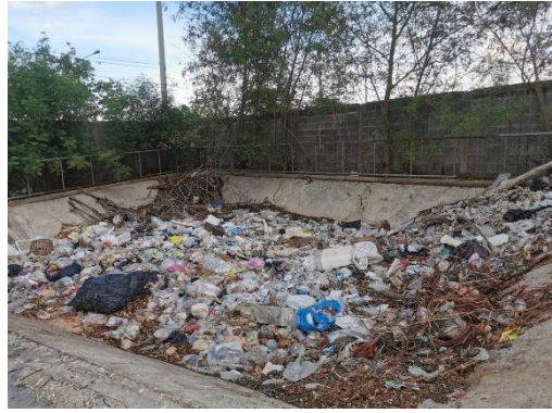
ขยะปลิวลงเต็มบ่อรองรับน้ำชะขยะ
