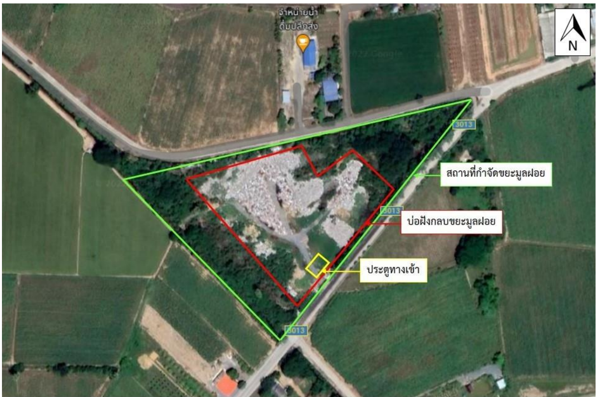
สถานที่กำจัดขยะมูลฝอยของ เทศบาลตำบลสระยายโสม จังหวัดสุพรรณบุรี
