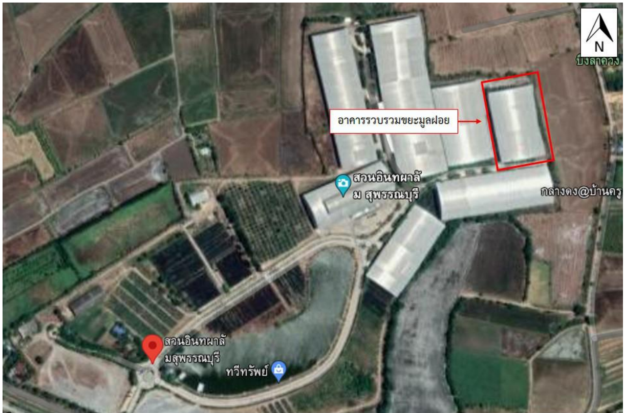
สถานที่กำจัดขยะมูลฝอยของ ห้างหุ้นส่วนจำกัด ไสสะอาดบุรี จังหวัดสุพรรณบุรี
