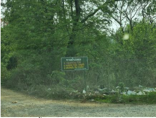
ไม่มีรั้วรอบสถานที่กำจัดขยะมูลฝอย
