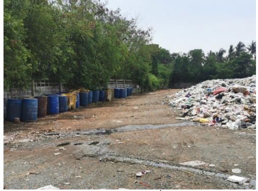
ถนนภายในสถานที่กำจัด
