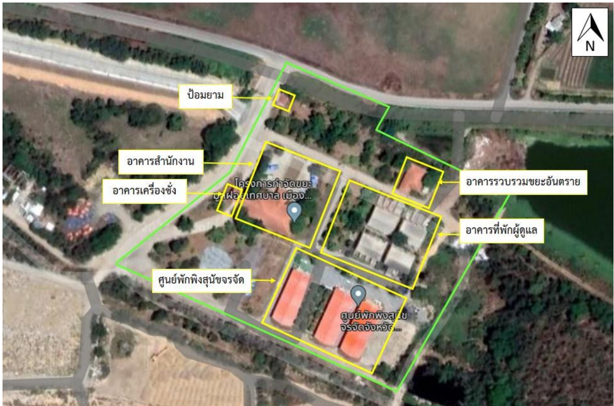
โครงสร้างพื้นฐานภายในสถานที่กำจัดขยะมูลฝอยของ เทศบาลเมืองสุพรรณบุรี จังหวัดสุพรรณบุรี
