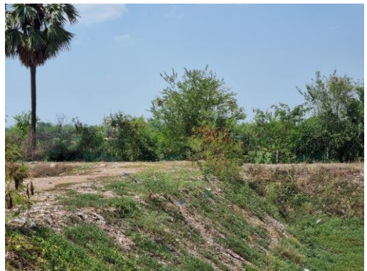
ริ้วบางจุดไม่ได้ติดตั้งตาข่ายกันขยะปลิว
