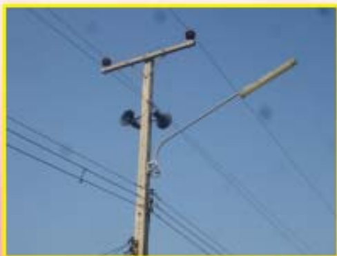
ติดตั้งสายตามสายหมู่ 3
