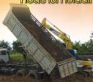
สร้างเสริมถนนดินพร้อมลงลูกรังหมู่ 2,4,5
